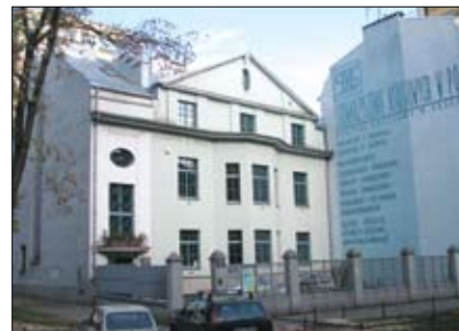
Siedziba Oddziału Okręgowego SKwP w Krakowie
